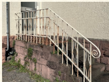
Das Geländer am Treppenaufgang stammt aus der Schule von Hermann Billing.
